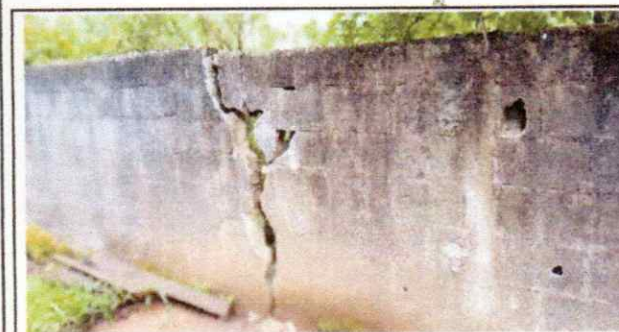
Foto 5: REPARACIÓN DE PAREDES.
