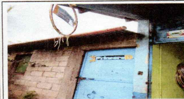
Foto 3: ELEVACIÓN DE PAREDES DE LA COCINA.
