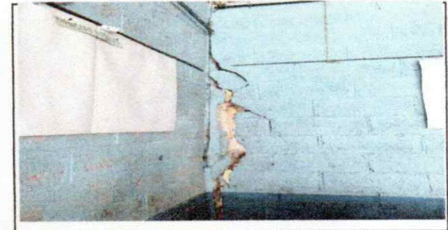
Foto 6: REPARACIÓN DE PAREDES.
