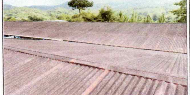
Foto 2: MEJORAMIENTO DE ENTECHADO, SUSTITUYENDO LAMINAS VIEJAS Y DETEREORADAS POR LAMINAS TROQUELADAS
