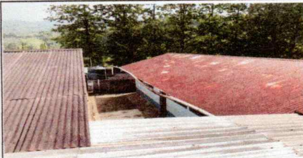
Foto 1: MEJORAMIENTO DE ENTECHADO, SUSTITUYENDO LAMINAS VIEJAS Y DETEREORADAS POR LAMINAS TROQUELADAS
