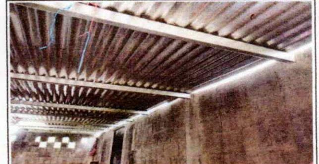
Foto 4: ELEVACIÓN DE PAREDES DE LA COCINA.
